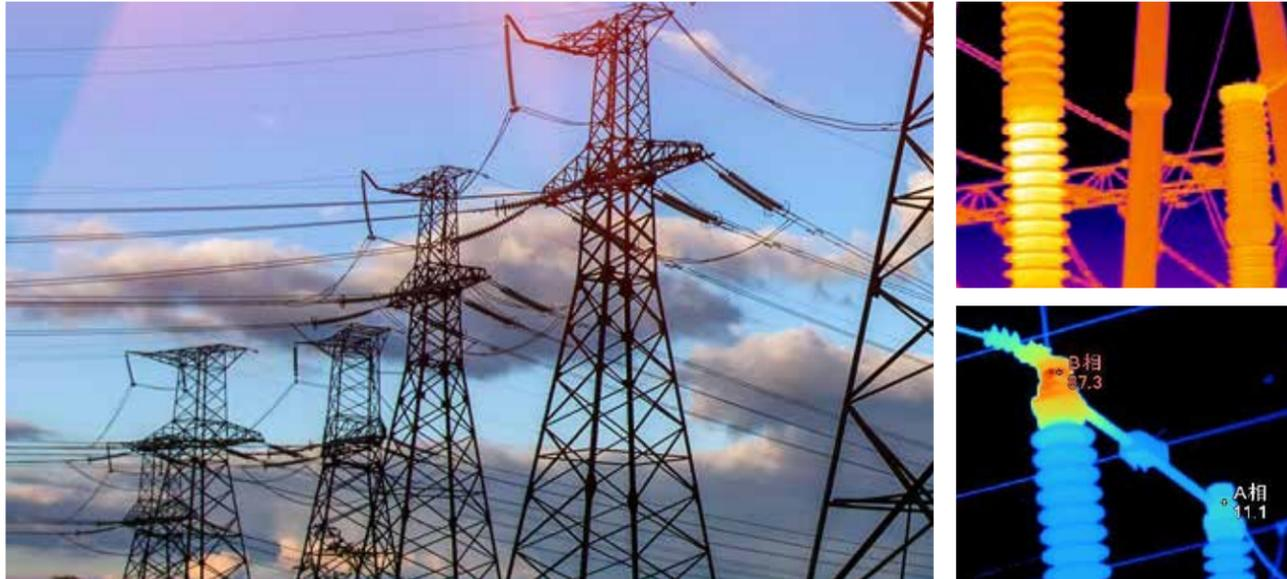
变电站在线测温系统，可通过非接触式方式检测变电站中各设备温度，实现 7x24 小时实时巡视，可直观、精确定位电力设备过热位置。结合后端管理平台，可实现实时预置位测温、温度曲线分析、温度报警提示、图片抓拍等功能。系统可有效预防变电站中各电气故障的发生，有效保障电力系统正常稳定运行。
